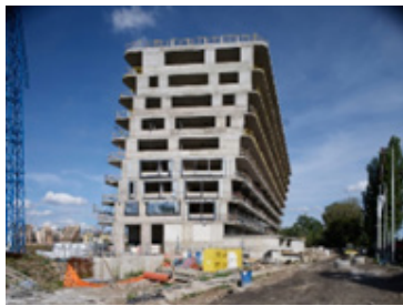
شکل ۲۰. سازه بتنی و دیوارهای برشی منبع: (T2.a, 2020)
