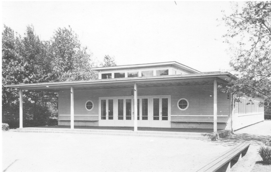
تصویر ۴. ساختمان مهد کودک هایم و کمپتر که اخیراً در اثر آتش سوزی ویران شده است (منبع: موزه معماری در وروتسواف).
