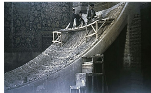
ت ۱۰: لنگه گچی ساخته شده برای مرمت گنبد جامع عباسی اصفهان منبع: آرشیو میراث فرهنگی استان اصفهان
