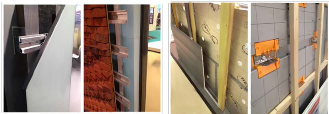
شکل‌های ۶، ۷، ۸ و ۹. نمونه‌هایی از سازه و پوشش نمای تهویه‌شونده (Konstantinou, 2014)
