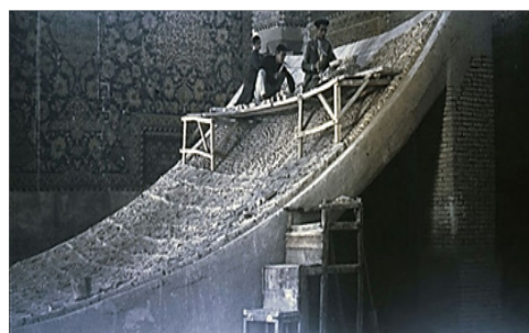
ت ۱۰: لنگه گچی ساخته شده برای مرمت گنبد جامع عباسی اصفهان منبع: آرشیو میراث فرهنگی استان اصفهان
